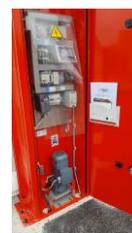
Le poteau de réception type caisson emprisonnant l'extrémité avant du vantail et rigidifiant l'ensemble de l'installation en position fermée, dispose d'un reposoir et d'un guidage latéral réglables. Une butée arrière avec reposoir est fournie avec chaque portail. Les cellules de sécurité sont à l'abri du vandalisme et des intempéries derrière des pareclozes démontables.
